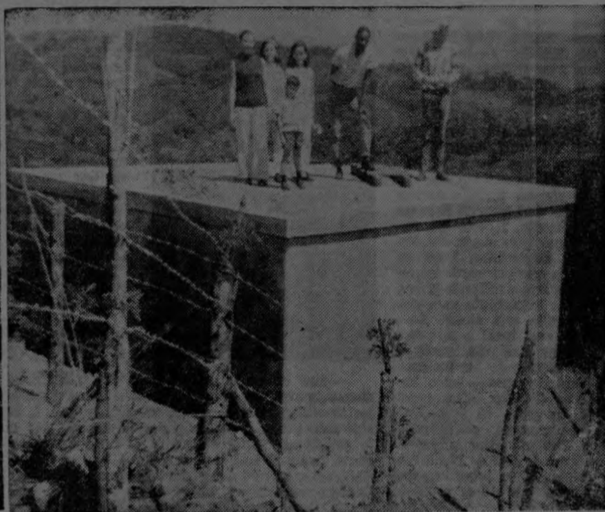
Tanque de distribución, de concreto, del acueducto de San Rafael de Platanares, que tiene una capacidad de 45.000 litros.
